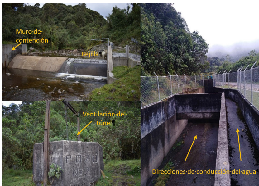
Figura 2. Infraestructura de los pozos y las captaciones del sistema Chingaza
